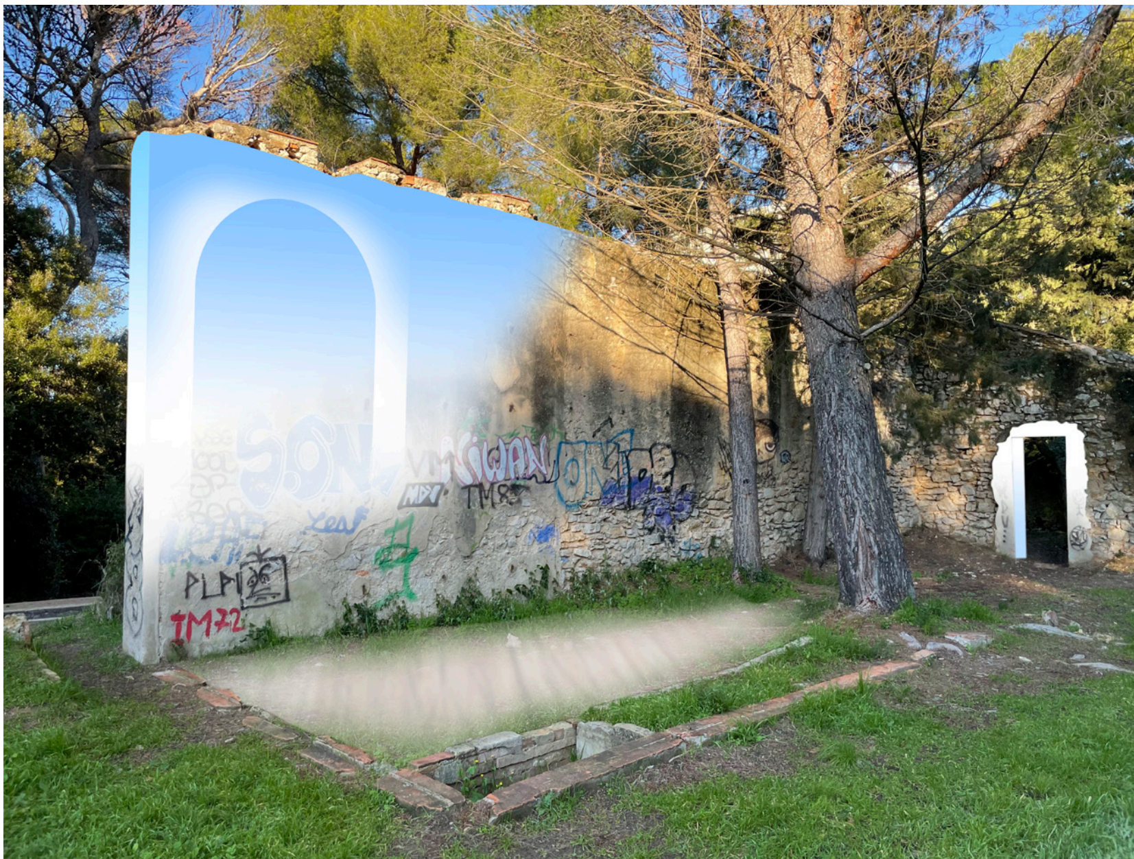
Mur principal orienté vers le Sud. Un enduit à la chaux avec un dégradé bleu ciel est réalisé sur le mur. Une arche est représentée sur le mur principal. Le reste de porte est lui aussi enduit de chaux, créant un jeu de perspective entre l'arche réelle et la fresque.
